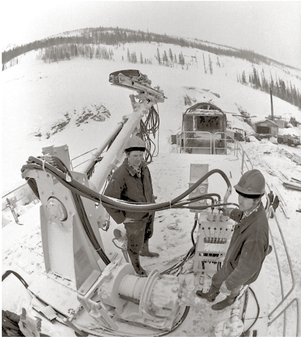
Строительство БАМа, 1977 г.
