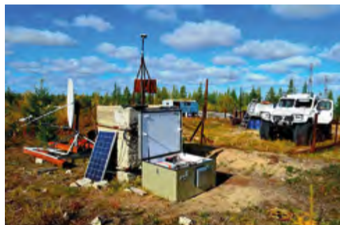
Пример технологического решения с ЭХГ «Топаз»
