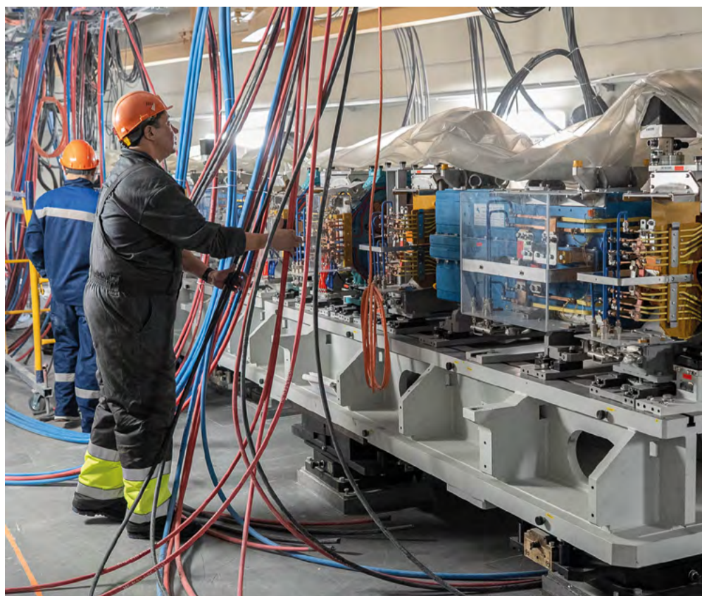
Установка оборудования основного накопительного кольца
